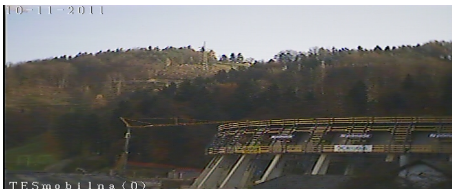
Slika 7: Pogled proti gradbišču ob 15:00 uri
