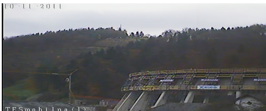
Slika 6: Pogled proti gradbišču ob 9:00 uri
