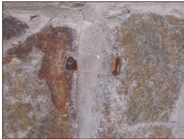
Slika 26: Pogled na razpoko in stekleno plombo na fasadnem podzidku
